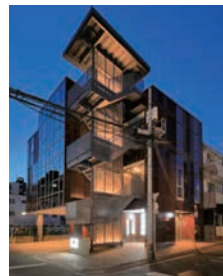
エレベスト南坪井 上乃裏通りに建つテナントビル。鉄骨造3階建
